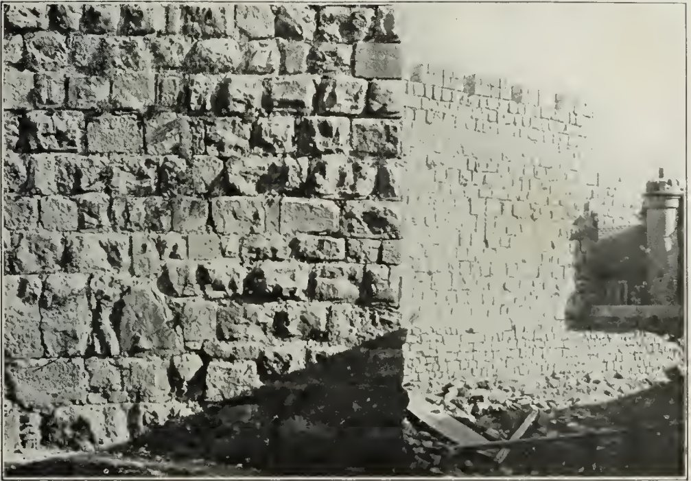
1. — Jérusalem : angle N.-O. vu du N. Au fond, à droite, atelier de phot. Grégorian. En avant, sous le mur en pierres sèches, le blocage du mur antique démantelé.
